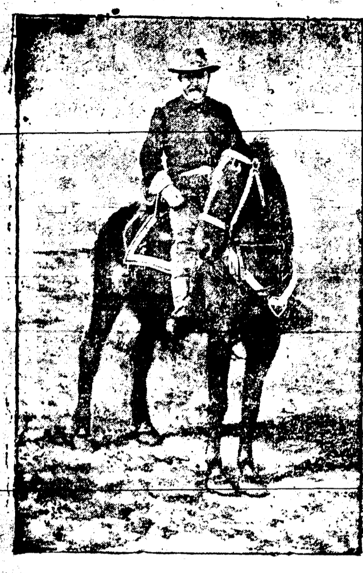
Le général Grant inspecte les casernes Jackson.
