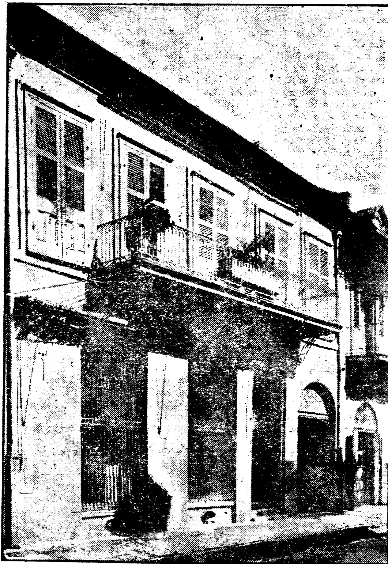
Comme on parle actuellement de la réhabilitation de certaines de nos vieilles maisons nous publions ici la photographie de la vieille maison financière Lafitte et Dufilho, qui se trouve dans la rue St. Louis, entre les rues de Chartres et Royale. Ce vieux bâtiment, d'une architecture des plus antiques, est peu connu, même de beaucoup des habitants de la Nouvelle-Orléans.
